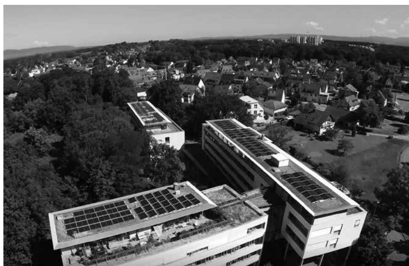
Die nach Osten und Westen ausgerichtete Anlage nutzt die Dachflächen der drei Gebäudeteile des Weihbischof-Gnädinger-Hauses optimal aus.
