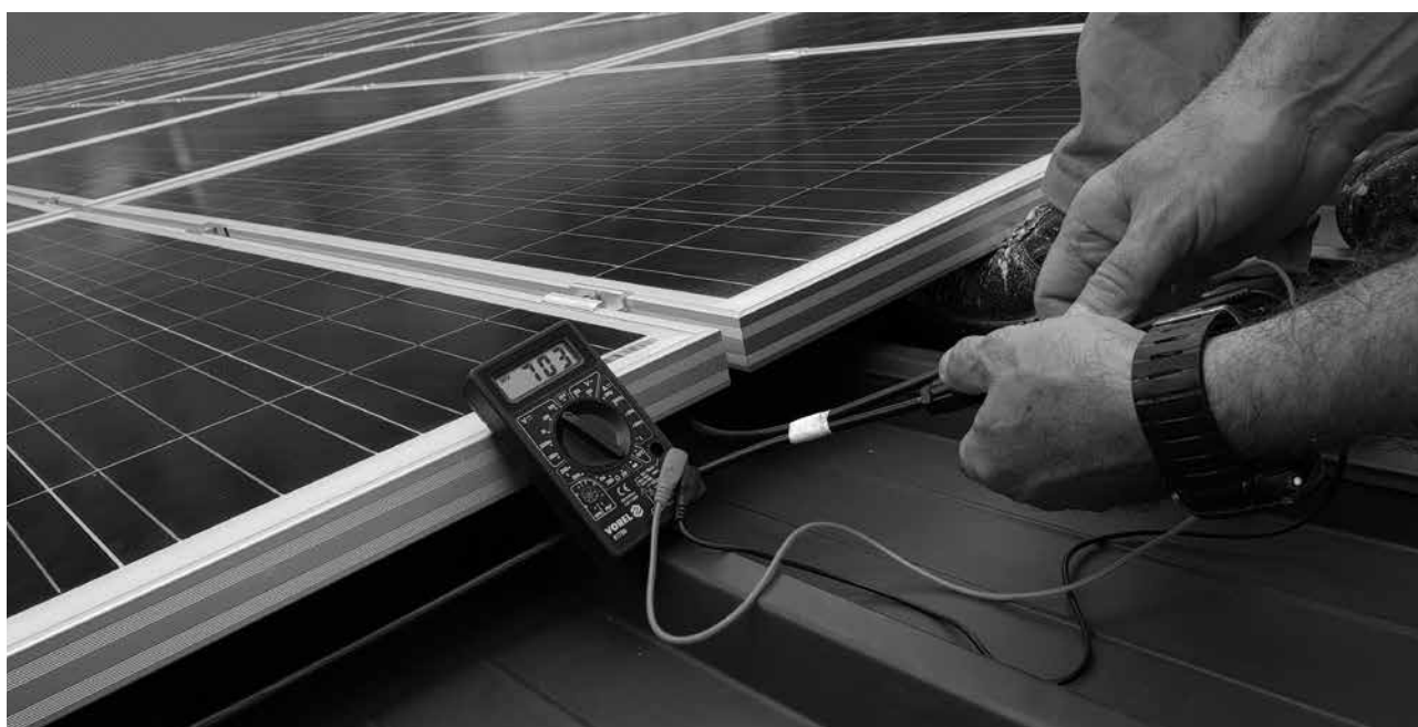
Einiges hat der Verband schon getan: auf sechs seiner Gebäude sind insgesamt acht Photovoltaikanlagen installiert.
